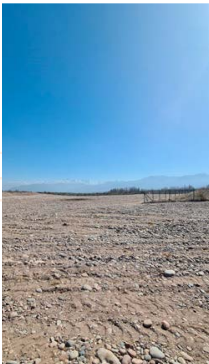
Preparación de terreno
